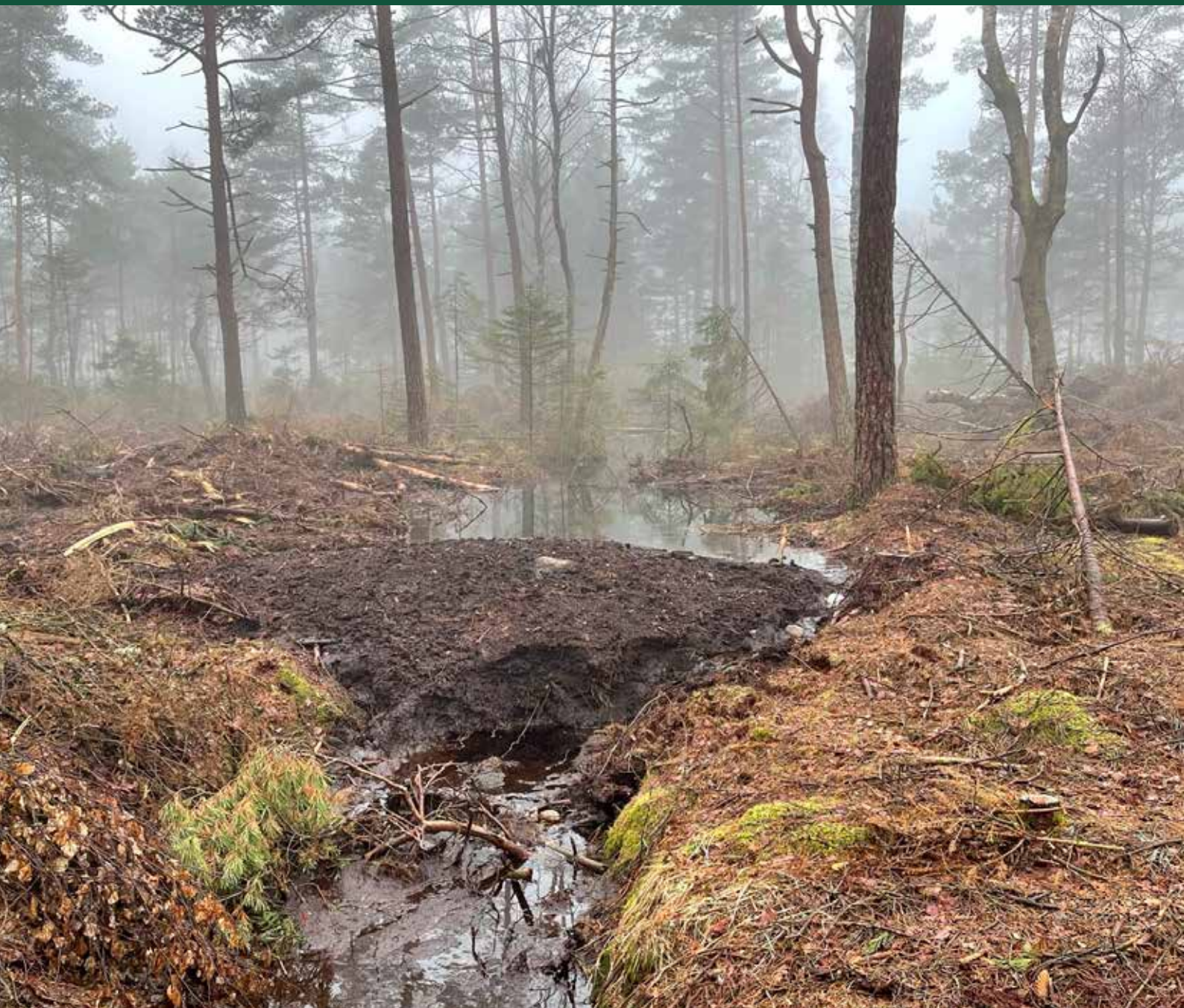
Återvätning av en tidigare dikad mosse i Halland med en s.k. propp.
