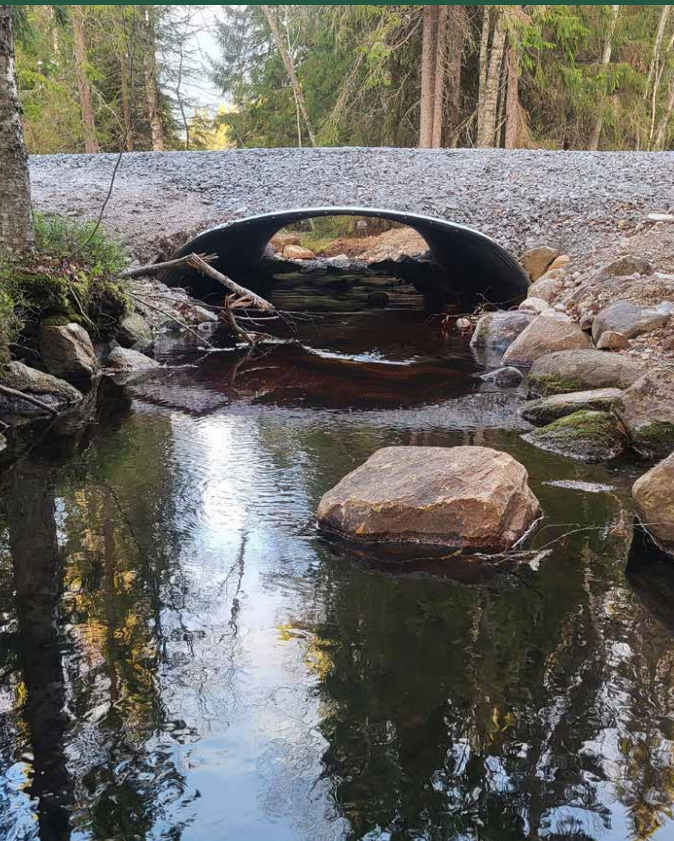
Valvbåge med naturlig bäckbotten i Laxbäcken, Svartnäs.
