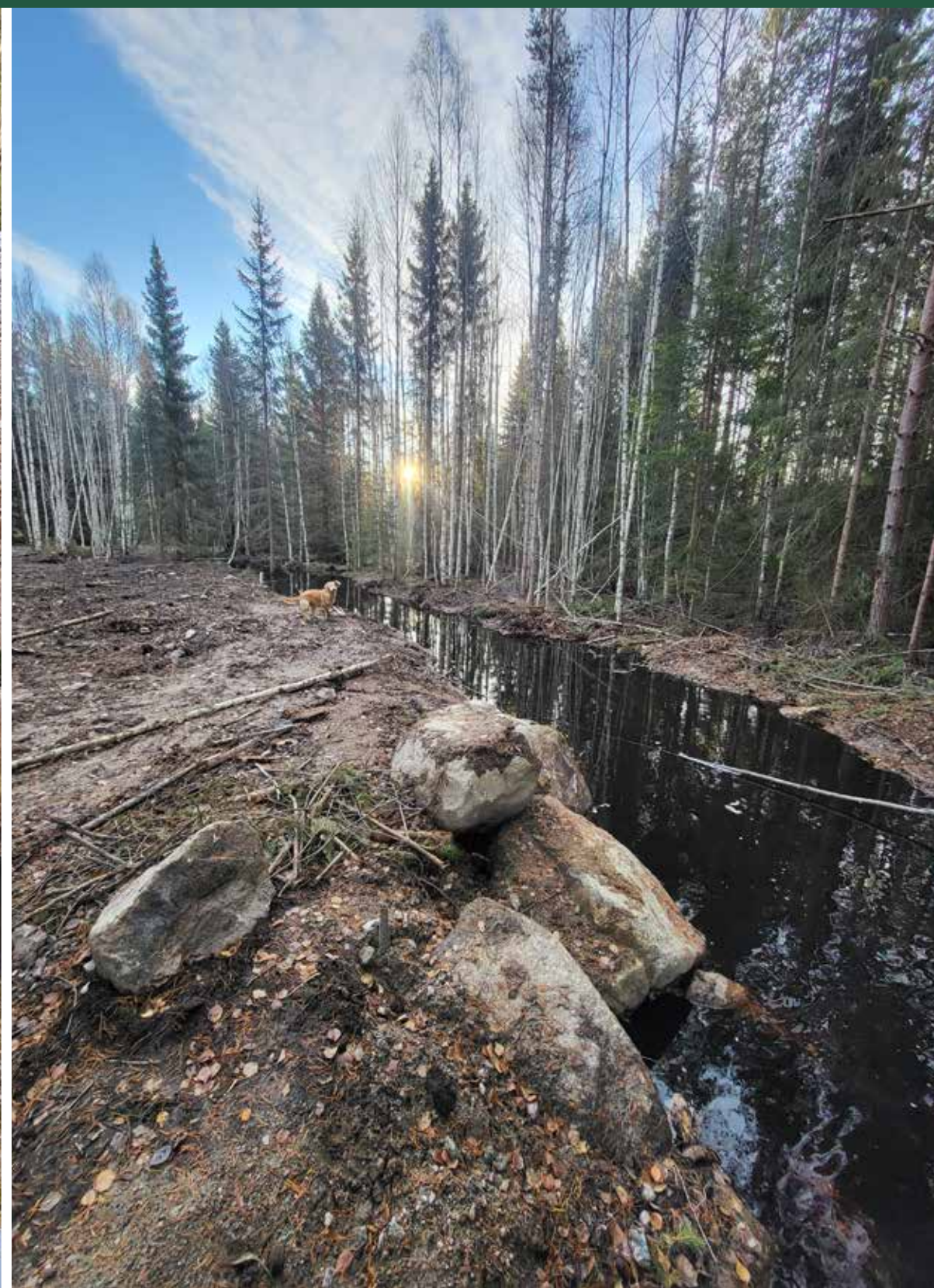
Enrisbäcken har återfått sin naturliga strömfåra ner i lövsumpskogen efter att kanalen till vänster på bilden har lagts igen.
